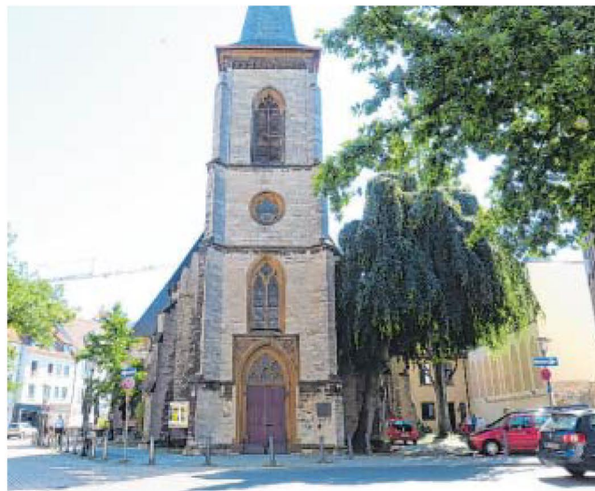
Süsterplatz von Südwesten aus: Die prägende Kirche als maßgeblicher Eigentümer dominiert den Platz, hat aber selbst ihren Ausgang in einem platzfernen Bereich. Sie selbst regt an, auch ihren Innenhof (rechts) mit als Teil des Süsterplatzes zu sehen. FOTO: KURT EHMKE
